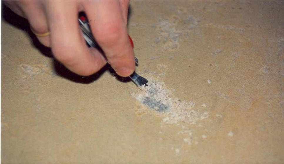
**Abbildung 3:** Aufgeweichtes, mechanisch leicht zu entfernendes Material aus einem geschädigten Bereich
