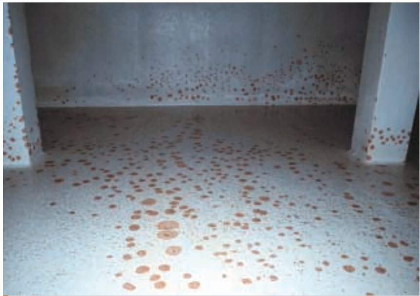
Abb. 1: Fleckige Korrosion ungeeigneter Mörtelauskleidungen in Trinkwasserbehältern
